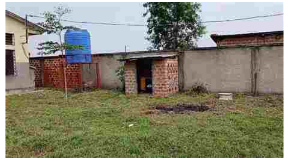
Generador y depósito de agua 26 de junio de 2025
