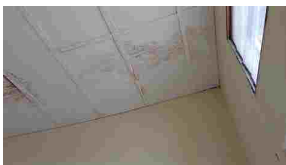
Techo del espacio de almacenaje de galletas 26 de junio de 2025
