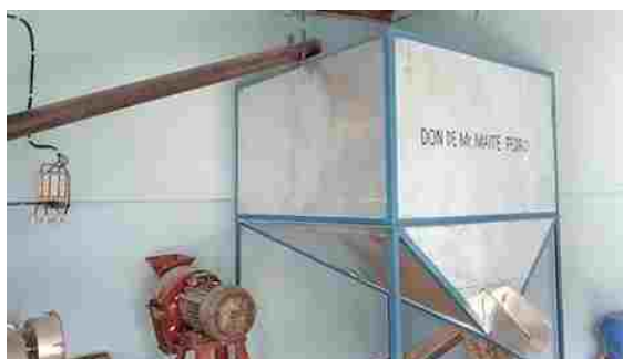
Silo de almacenamiento (donación privada) 26 de junio de 2025
