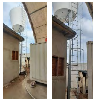
Figure 8: Une vue du château d'eau
