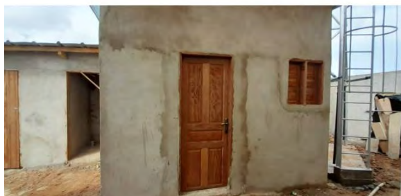
Figure 2: Une vue du bureau sur le site
