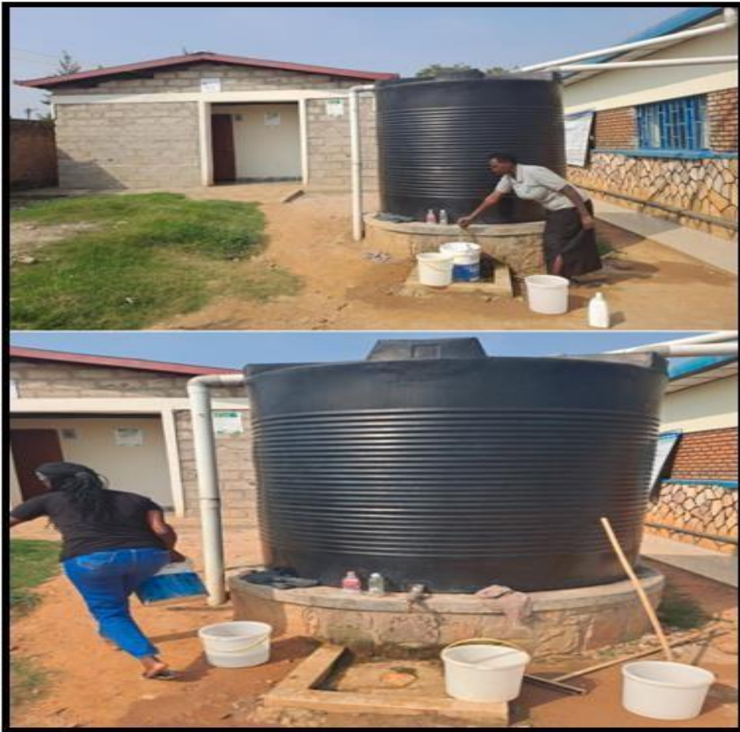
Figure 6 : Toilette publique au bureau du Secteur Runda. La toilette est nettoyée tous les matins.
