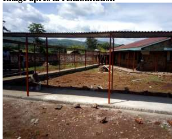
Image après la réhabilitation
