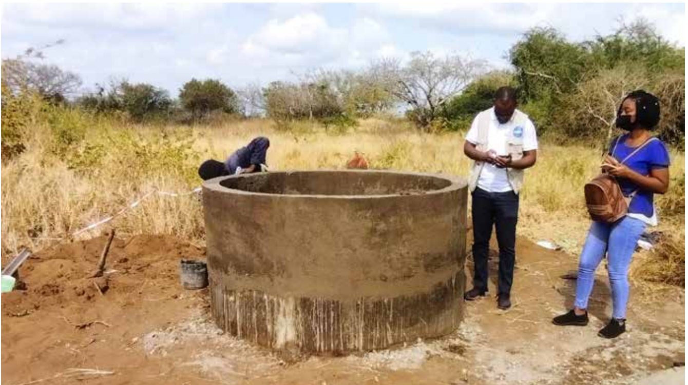
Construcción del sistema de agua de Agropec en Salamanga
