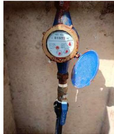
*Figura 114 – Medidor de caudal de la fuente Pública de Hakune Hogo.*
