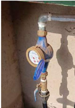
*Figura 113 – Medidor de caudal de la fuente privada de Parawol.*
