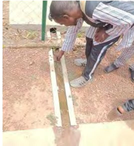
*Figura 71 – Piso parcialmente sin material de infiltración en la fuente Pública de Gaoloya.*
