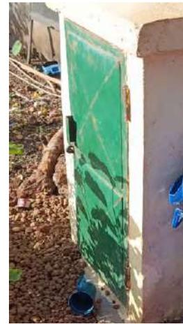
*Figura 98 – Detalle de la oxidación en puerta de contador de fuente privada de Parawol.*
