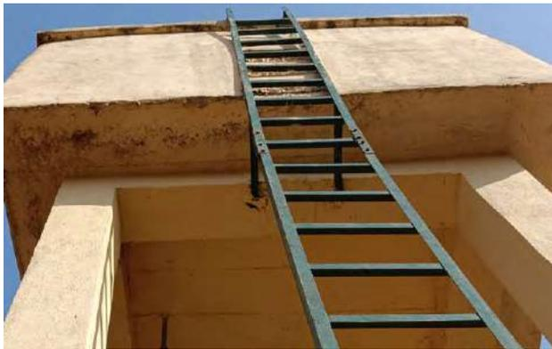
Figura 87 – Detalle de las infiltraciones en el depósito, y debilidades de la instalación del hormigón en la instalación de la escalera.
