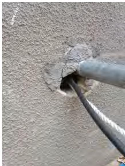
*Figura 43 – Agujero en pared de edificio técnico, derivado del pasaje de la tubería y cuerda de soporte de la bomba y cable eléctrico.*
