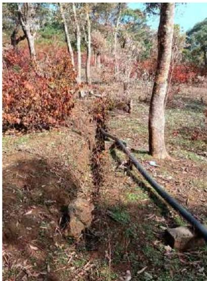
Figura 122 – Vista tubería de impulsión junto al pozo hacia el depósito (1) – Hérico
