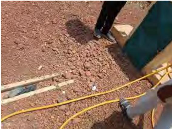
*Figura 70 – Canal de drenaje bloqueado por material de infiltración en la fuente Pública de Goundoupi.*
