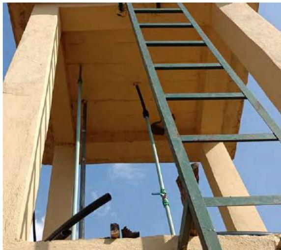
Figura 96 – Válvula de paso de tubería de limpieza de depósito de Pellel.
