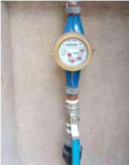
Figura 55 – Medidor de caudal de la fuente Gongoré.
