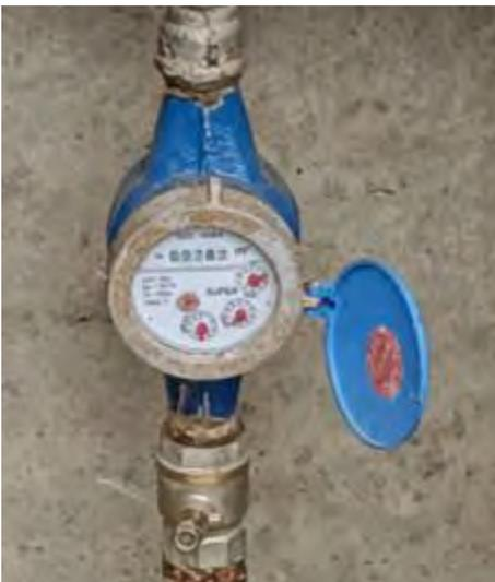
Figura 59 – Medidor de caudal de la fuente Saré.
