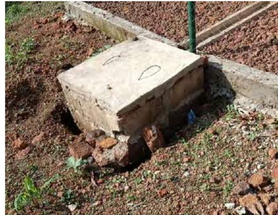
Figura 104 – Detalle de fundaciones de pozo de infiltración expuestas en fuente Pública de Tenke.
