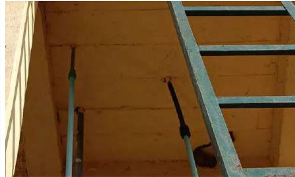
*Figura 92 – Detalle de un conector para cambiar de material de tuberías (PPR y acero inoxidable).*
