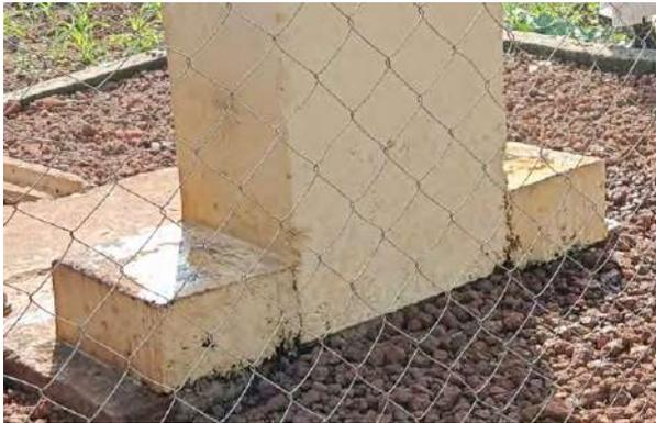
Figura 103 – Detalle de acabado de estructura de hormigón de poca calidad en fuente Pública de Tenke.
