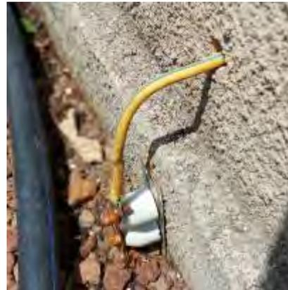
Figura 38 – Conexión a tierra del sistema fotovoltaico de Diari.
