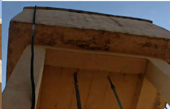
Figura 88 – Detalle de infiltraciones en el depósito.
