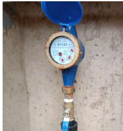
*Figura 116 – Medidor de caudal de la fuente Pública de Haregoubi.*
