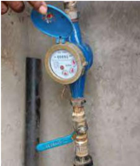
Figura 57 – Medidor de caudal de la fuente Fello.
