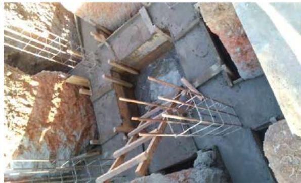
Figura 129 – Fundaciones de depósito de agua en construcción – Hérico.
