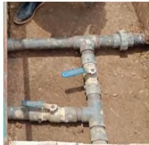
Figura 40 – Instalación de accesorios y válvulas de paso en Diari.
