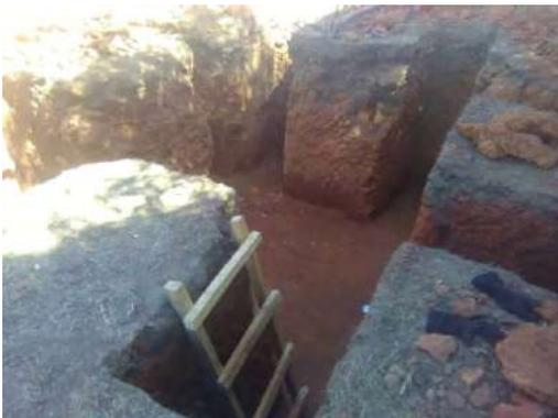
Figura 128 – Excavación de fundaciones de depósito de agua – Hérico.
