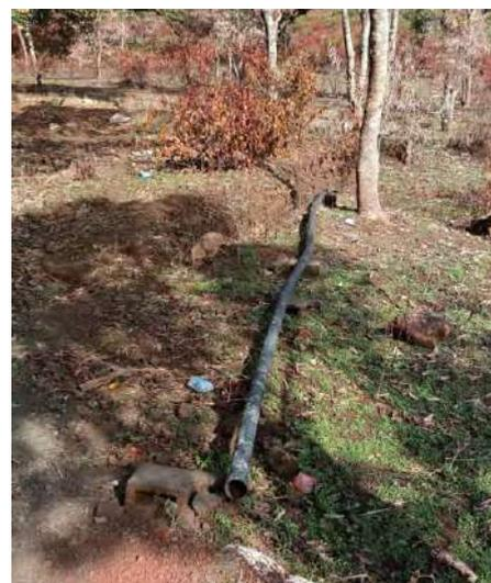
Figura 123 – Vista tubería de impulsión junto al pozo hacia el depósito (2) – Hérico
