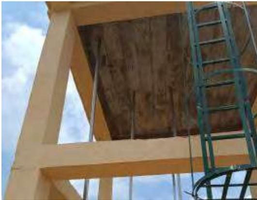
Figura 37 – Detalle de estructura de concreto de depósito elevado de Diari (sin manifestación aparente de infiltraciones).
