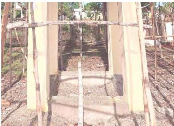
Figura 130 – Fundaciones de depósito de agua (1) – Hérico.
