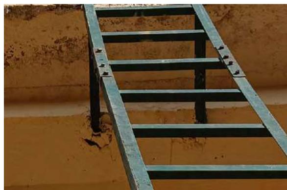
Figura 89 – Detalle de las debilidades de la instalación del hormigón en la instalación de las escaleras donde se aprecia su oxidación.
