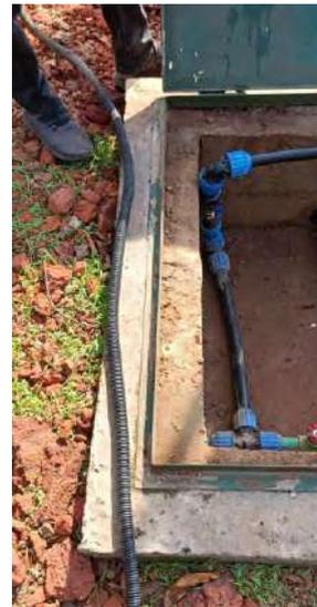
*Figura 94 – Detalle del cable de la sonda de control de bombeo expuesta.*
