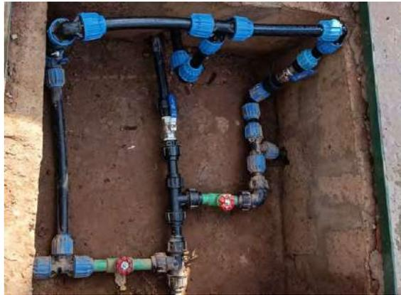
Figura 95 – Detalle de conexiones de la Arqueta de llaves de paso.
