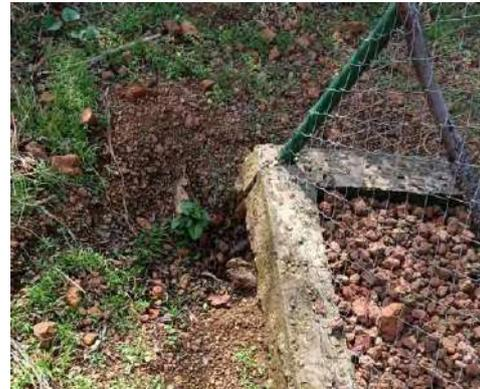
*Figura 100 – Detalle de fundaciones expuestas e inicio de los daños en fuente Pública de Haregoubi.*
