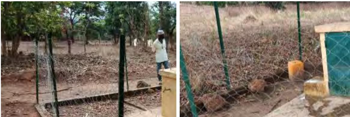
*Figura 42 – Ejemplos de áreas en donde la malla metálica de las vallas están comprometidas.*
