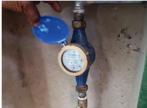
Figura 117 – Medidor de caudal de la fuente de la mezquita de Pellel.
