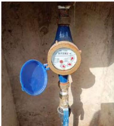
*Figura 115 – Medidor de caudal de la fuente Pública de Tenke.*
