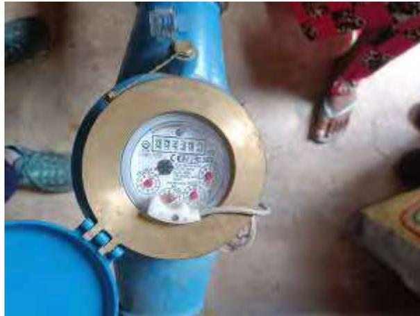
Figura 50 – Medidor de caudal de la captación.
