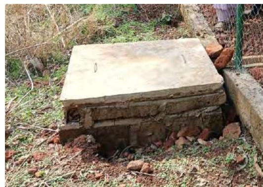
*Figura 102 – Detalle de pozo de infiltración expuesto y daño en su esquina, en fuente Pública de Haregoubi.*
