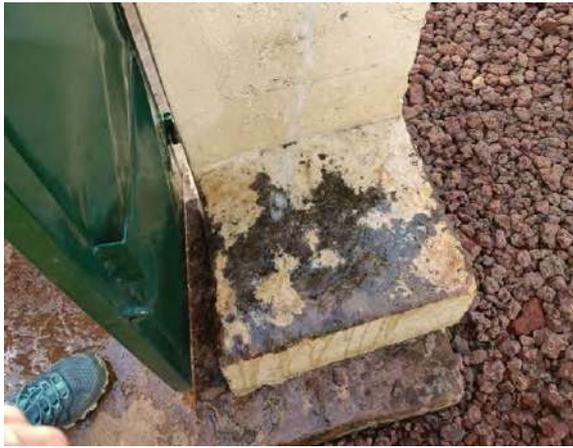
*Figura 97 – Detalle de falta de pintura en fuente Pública de Haregoubi.*
