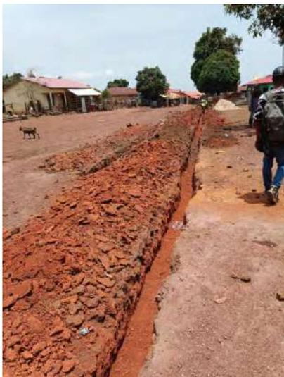
Figura 126 – Excavación de zanjas para tubería (1) – Hérico.
