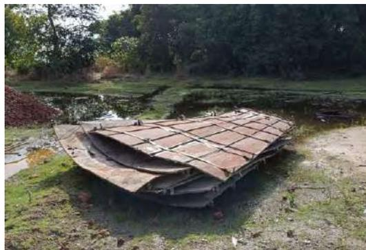
Figura 134 – Encofrado para construcción del de depósito de agua – Hérico
