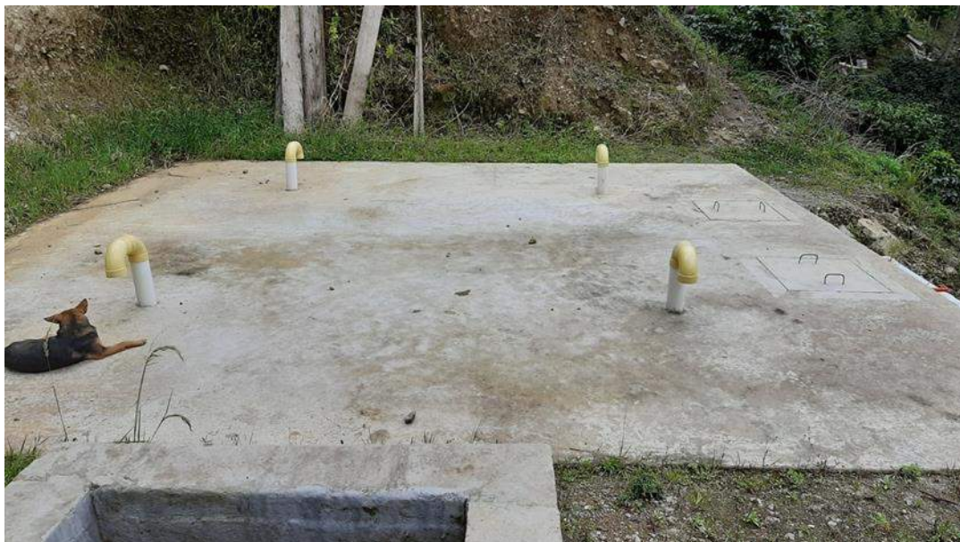
Figura 18. Cubierta del tanque de almacenamiento
