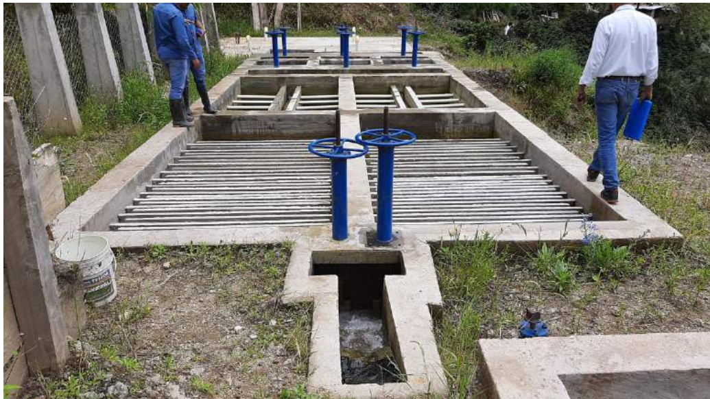
Figura 12. Floculadores de pantalla horizontal
