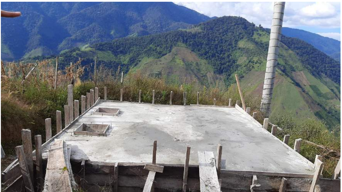
Figura 28. Tanque de almacenamiento finalizando la etapa de construcción
