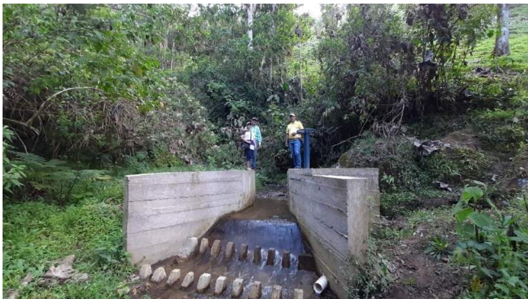
Figura 23. Captación en la quebrada Palma Brava
