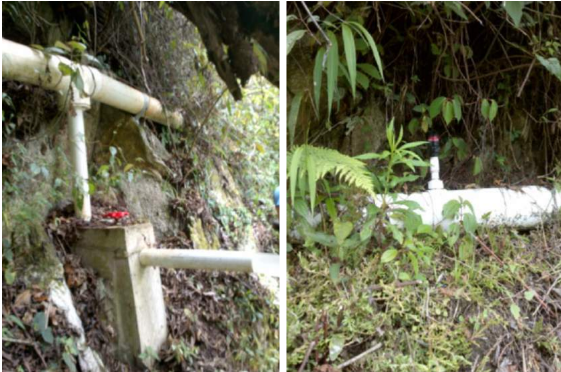
Figura 5. Imágenes de la conducción de aducción
