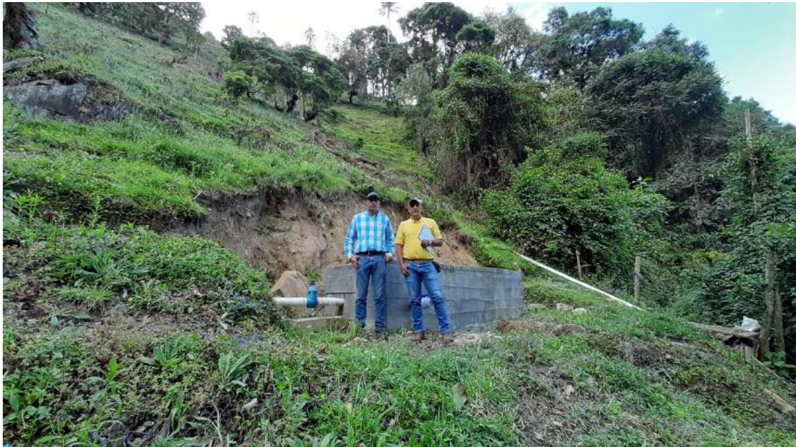
Figura 26. Vista del desarenador del acueducto Aguas del Progreso
