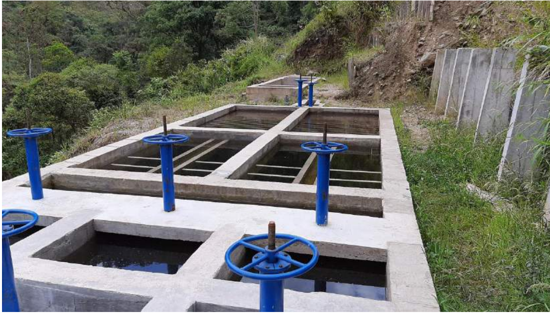
Figura 16. Filtros de arena (3 módulos)
