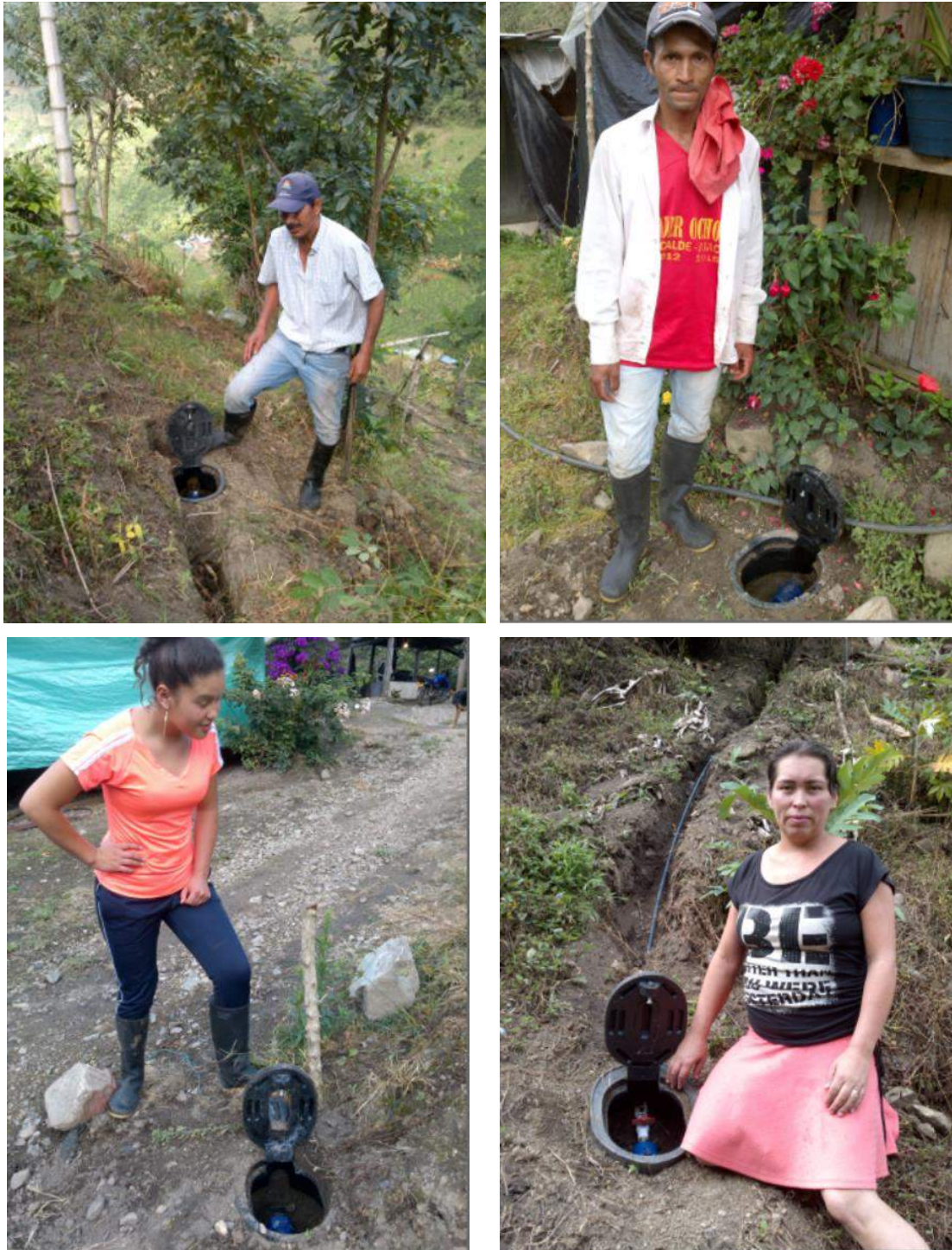
Figura 20. Dosificación de cloro y entrada regulada por válvula de flotador
